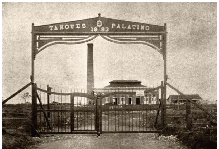
Casa de bombas en los tanques de Palatino, acueducto de Albear, 1893
