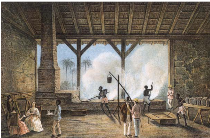
«Vista de una casa de calderas»
