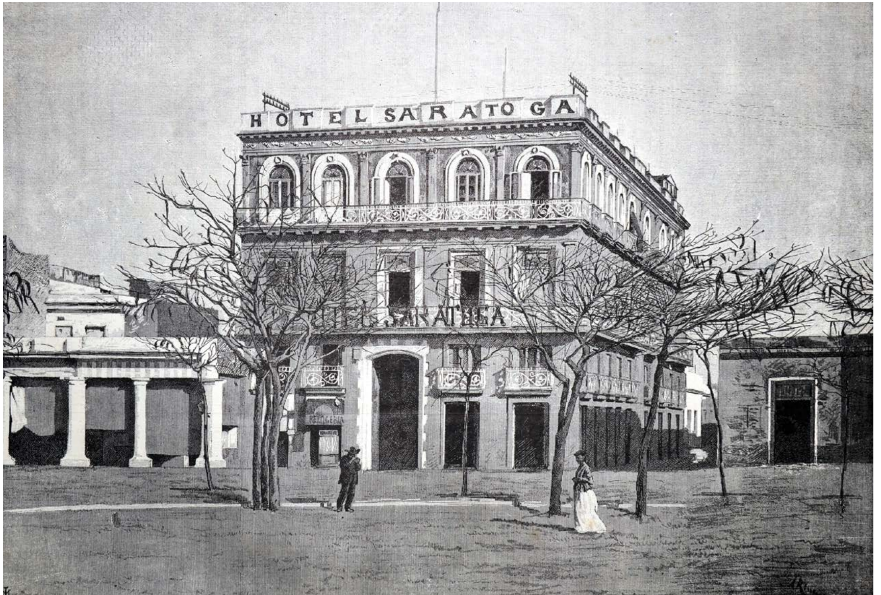
Hotel Saratoga, fotografía de Gómez de la Carrera
