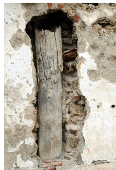
161. MURO DE LADRILLO Y HORCONES.
