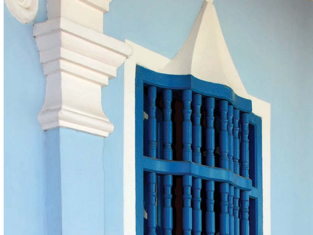
307. DETALLE DE LA REJA EN VUELO MIXTILÍNEO DE LA CASA DE LA TROVA, CRISTO ENTRE CAÑADA Y ALAMEDA.
