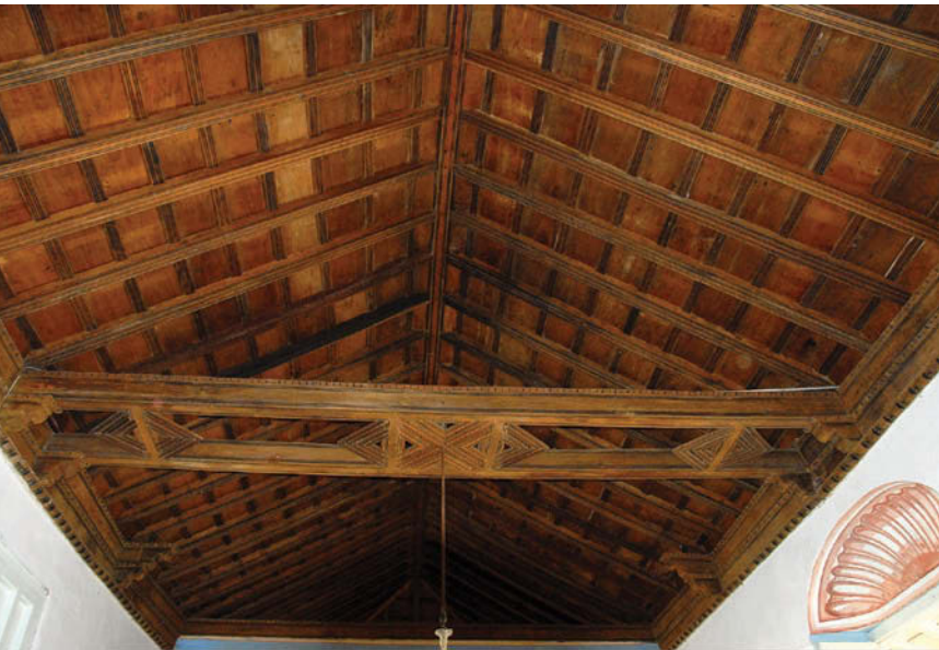
299. TECHO DE LA CASA DE LAS SÁNCHEZ IZNAGA.
