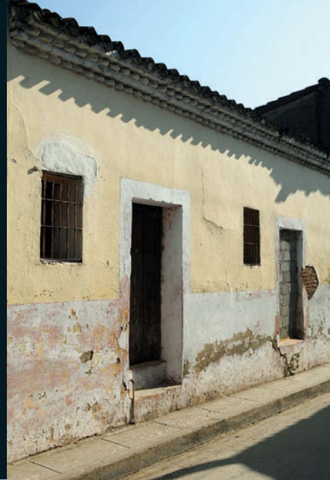
381. COLGADIZO DEL CALLEJÓN COCO ANEXADO A VIVIENDA ESQUINA CÉSPEDES. Estas estructuras, inicialmente independientes, están construidas en ladrillo y responden a los tipos de fines del siglo XVII y primeras décadas del XVIII. En su mayoría han sido asimiladas a viviendas o edificios construidos con posterioridad. Se distinguen por la fachada cerrada, con vanos a modo de pequeñas ventanas.
