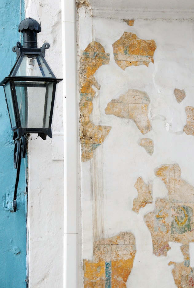
540. MUROS DE CANTO CON ESGRAFIADOS.
