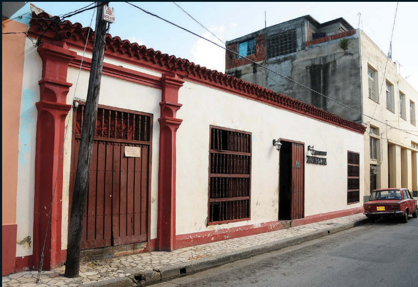
175. CASA DE FIGUEREDO 62. Esta antigua casa fue remozada a principios del siglo XIX, momento en que se transformaron los vanos de la fachada y se adicionó una guarnición «barroca» a la puerta de entrada, trasladada a un costado. Es uno de los pocos ejemplos de vivienda con zaguán.
