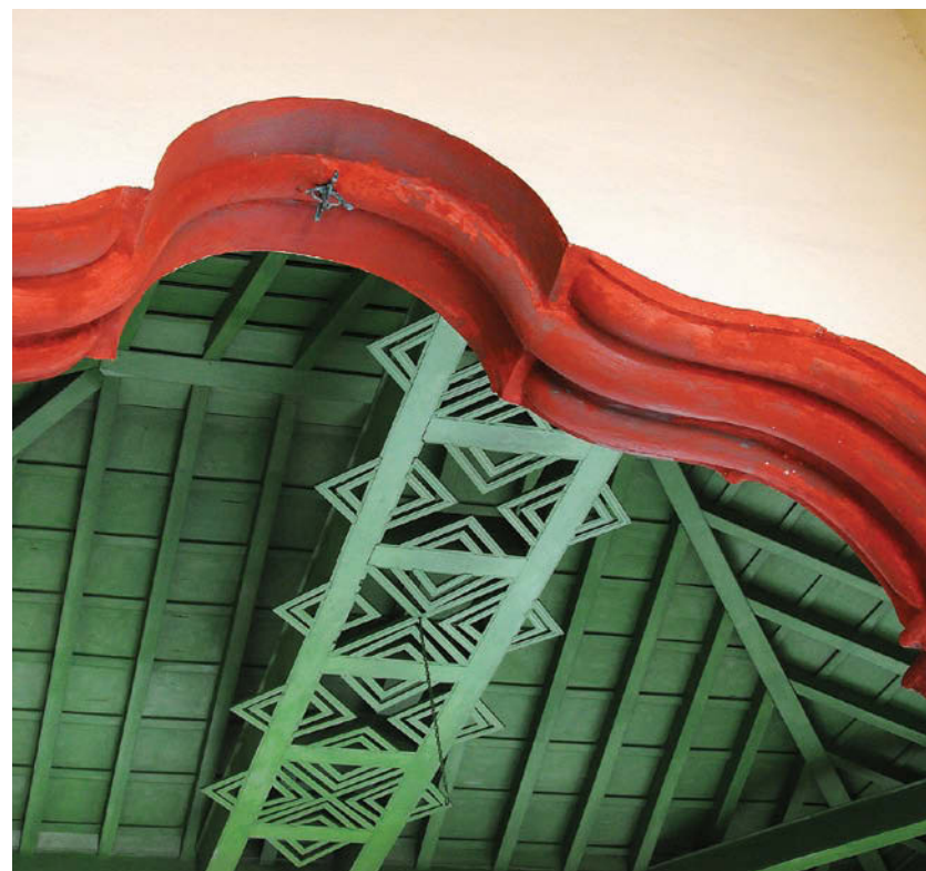
249. ARCO LOBULADO CON LA SILUETA RESALTADA CON NERVIO «NEOGÓTICO», GENERAL GÓMEZ 208; AL FONDO ARMADURA DE PAR E HILERA CON TIRANTE REALZADO CON REINTERPRETADA LACERÍA.
