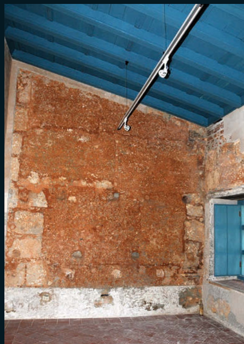
539. MUROS DE TAPIALES.
