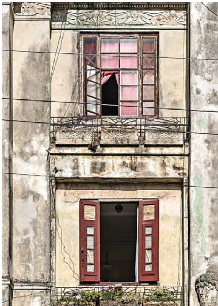
Fig. 44. Castellá y Lecuona, Finestre dell'apartment hotel di calle 8 e 19 , 1930 ca., L'Avana, Vedado. Foto A. Cannatello.
