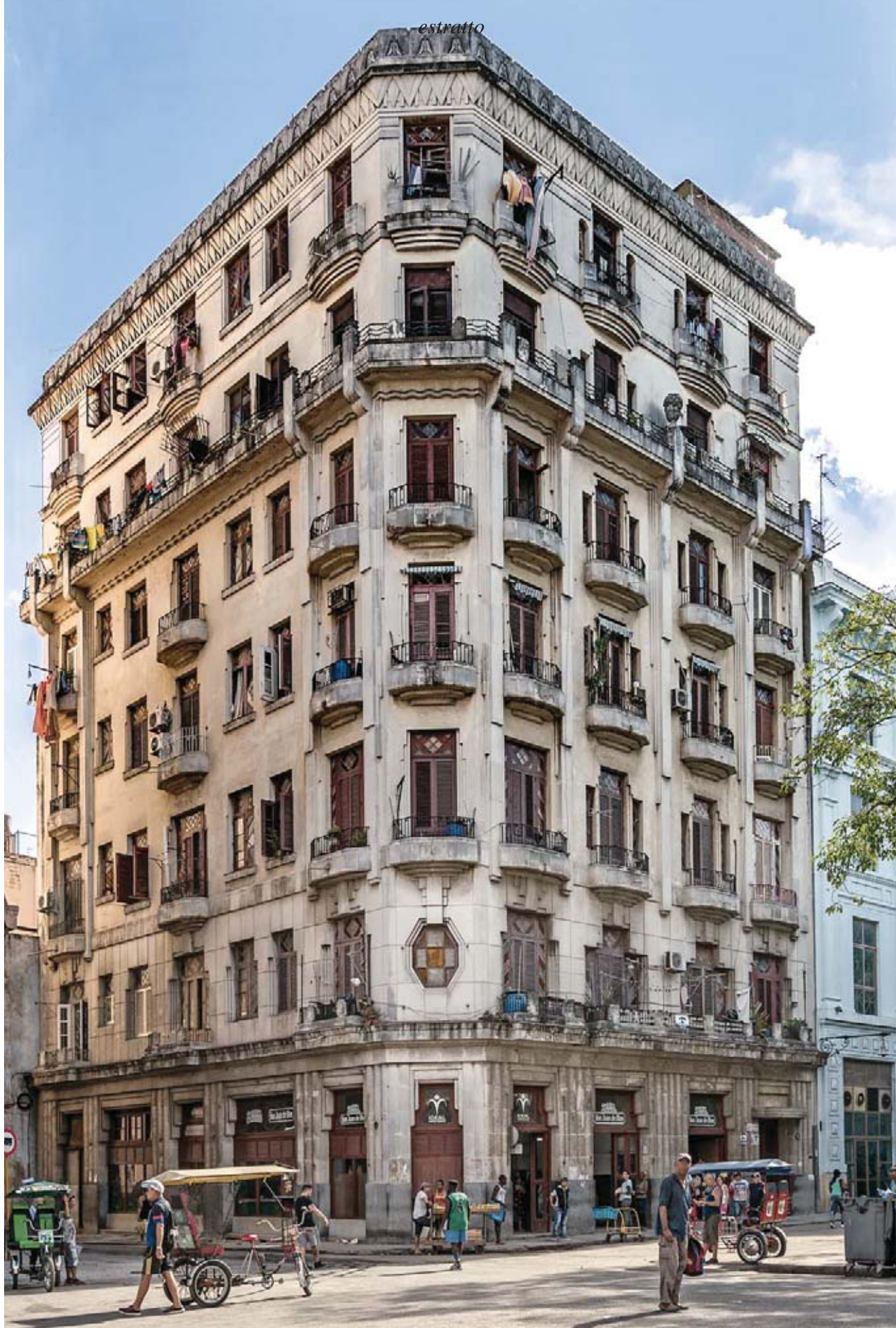
Fig. 101. Alejandro Capó Boada, Edificio per appartamenti , 1937, L'Avana, Monserrate n. 301, angolo con San Juan de Dios. Si veda M. E. MARTÍN ZEQUEIRA, Havana Art Deco cit. , pp. 50-51. Foto A. Cannatello.
