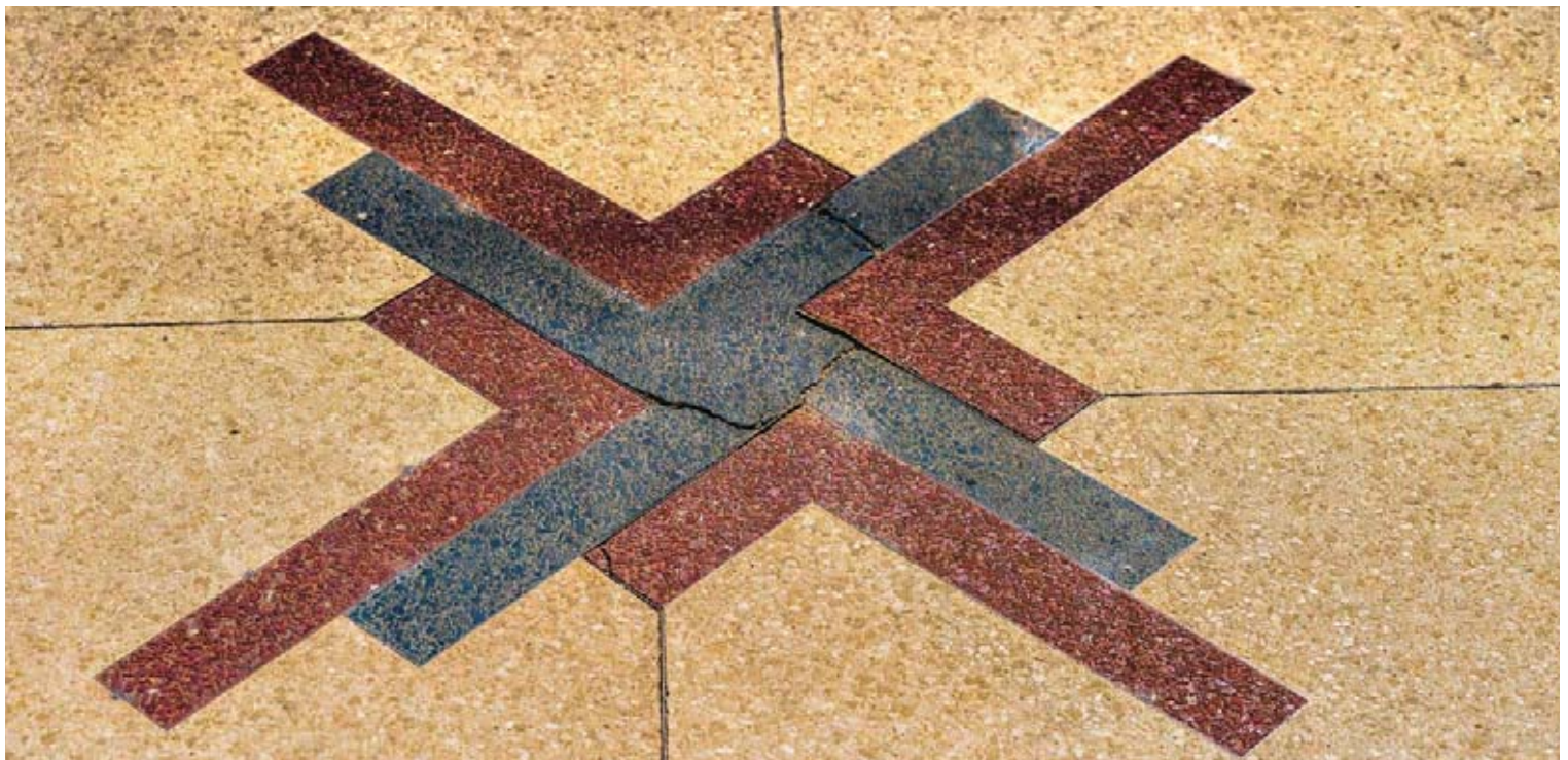
Fig. 36. Mira y Rosich, Edificio López Serranito , 1931, L'Avana, Vedado, calle 13 n. 106, tra L e M, particolare del pavimento della «lobby». Foto A. Cannatello.
