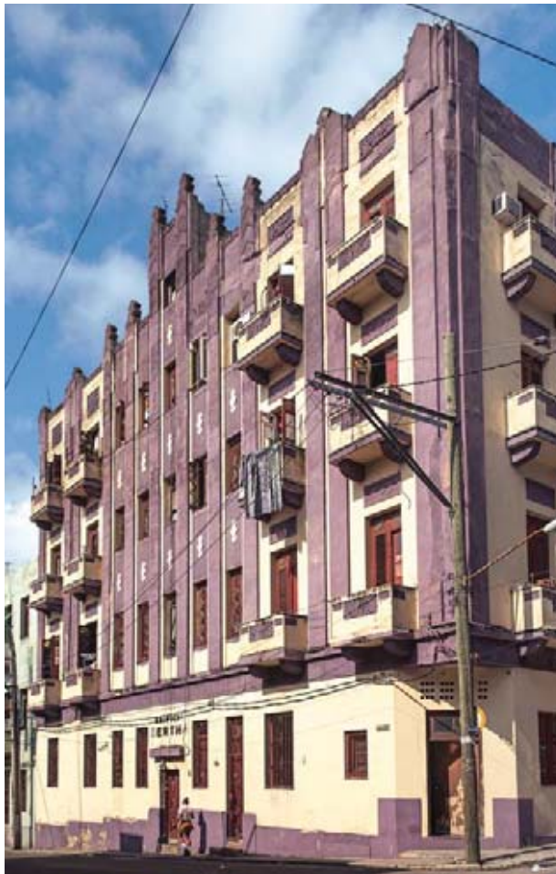
Fig. 86. Edificio Bertha , L'Avana, Maloja n. 502, angolo con San Carlos. Foto J. Larramendi.
