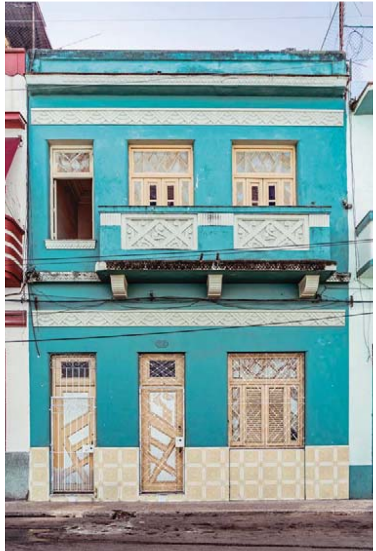
Fig. 90. Casa di Maloja , L'Avana, Maloja 813, tra Retiro y Plasencia. Foto A. Cannatello.
