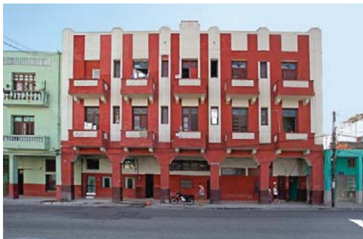
Fig. 113. Edificio per appartamenti , L'Avana, Calzada del 10 de Octubre n. 249. Foto A. Cannatello.
