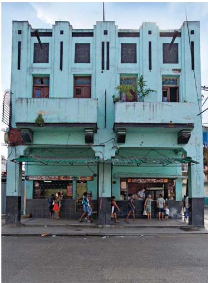
Fig. 116. Edificio per appartamenti , L'Avana, Calzada del 10 de Octubre nn. 287-289. Foto A. Cannatello.
