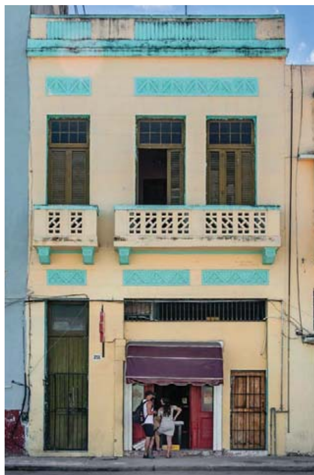
Fig. 79. A. Dalmau, Casa di Zanja , L'Avana, Zanja n. 355, tra Escobar e Cerrada del Paseo. Foto J. Larramendi.
